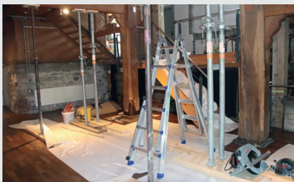
Die Mühle gut abgestützt
