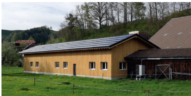
Neuer Werkhof-Wagenschopf mit PV-Anlage
