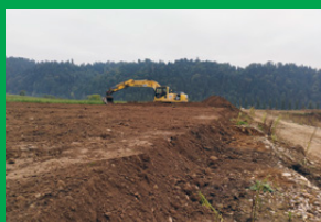
Der Umgang mit Boden erfolgt mit grosser Sorgfalt. Schichtweise wird dieser ab- und aufgetragen.
