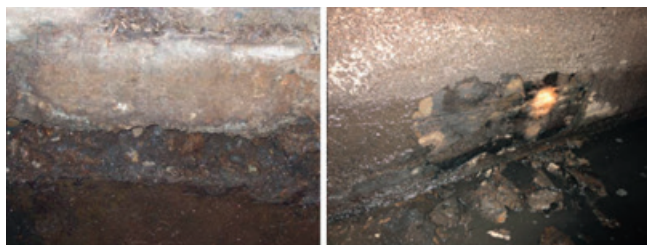
Abplatzungen – Die Gülle greift Armierung und Beton an – die Dichtheit und Statik sind nicht mehr gewährleistet.
