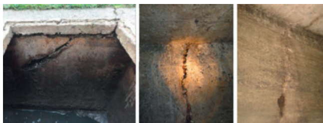
Risse in der Wand – Das Abwasser kann dadurch in den Untergrund, resp. ins Grundwasser gelangen.
