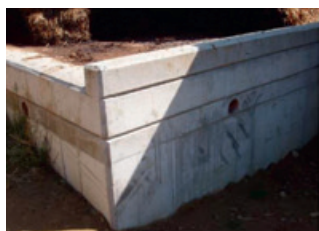
Lüftungslöcher seitlich – Es besteht Überlaufgefahr
